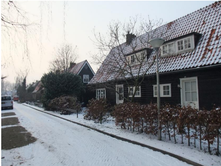
Complex met enkelvoudige en geschakelde Oostenrijkse woningen aan de De Keijzerstraat en omgeving in Zwolle (foto MAB, 2010). De woningen lijken in de opzet op die in Kaag en Braassem, maar de dakkapellen missen de lessenaarsdaken en de maatvoering van de gevelopeningen wijkt af.
