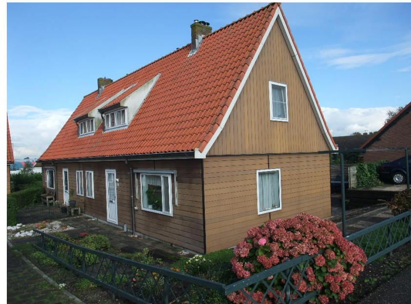
Wongblokken in Roelofarendsveen (boven) en Nieuwe Wetering (beneden).
